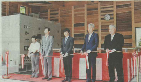
発電所建屋でテープカットする松崎将司社長(中央)ら—伊賀市奥馬野の馬野川小水力発電所で
